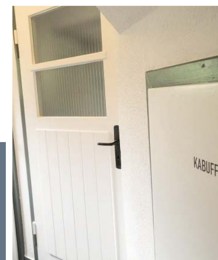
Restaurierung von Kellertüren
